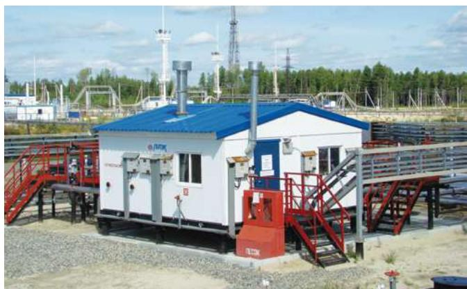
СИКН выполняется как открытого исполнения (на рамках), так и в отапливаемых блок-боксах. На площадке заказчика блоки собираются между собой согласно технологической схеме. Единой является и дренажная система. Силовая и контрольная кабельная разводка внутри блоков монтируется на заводе и выводятся на взрывозащищенные клеммные коробки. Внутри блок-боксов устанавливаются сигнализаторы загазованности и пожара, взрывозащищенные электроотопители, осветительная арматура и вентилятор.
