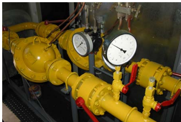
ГАЗОРЕГУЛЯТОРНЫЙ ПУНКТ ГРП.Б ВИД ВНУТРИ
