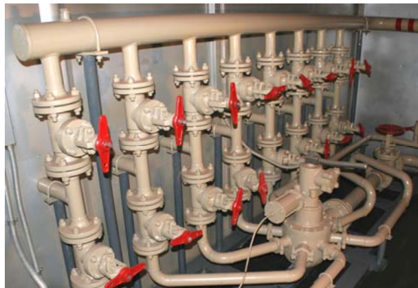
УСТАНОВКА ИЗМЕРИТЕЛЬНАЯ ГРУППОВАЯ «СПУТНИК-М». ВИД ВНУТРИ
