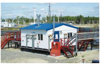
СИКН выполняется как открытого исполнения (на рамах), так и в отапливаемых блок-боксах. На площадке заказчика блоки собираются между собой согласно технологической схеме. Единой является и дренажная система. Силовая и контрольная кабельная разводки внутри блоков монтируется на заводе и выводятся на взрывозащищенные клеммные коробки. Внутри блок-боксов устанавливаются сигнализаторы загазованности и пожара, взрывозащищенные электроотопители, осветительная арматура и вентилятор.
